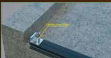
7.ติดตั้ง คลิป Starter บริเวณขอบหัวโครงตงทุกแผ่นตลอดระยะ
