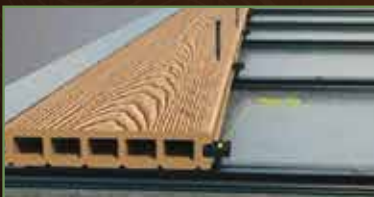
10.ติดตั้งคลิปพลาสติกบนโครงตงโดยให้เข้าล็อกกับแผ่นไม้พื้น
