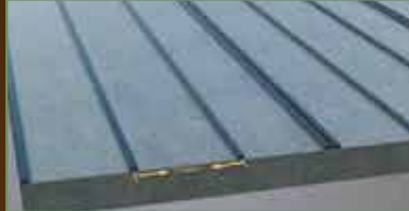
2.วัดเรียงระยะโครงตงโดยให้มีระยะห่างระยะโครง (Span) ที่ 30 ซม.
