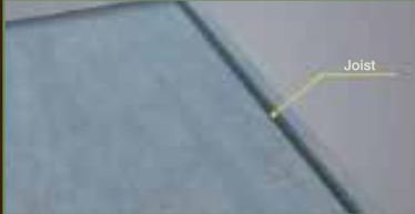
1.เตรียมพื้นคอนกรีตที่ปรับระดับแล้วเพื่อติดตั้งโครงตง (Joist) WPC
