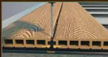
11.ติดตั้งไม้พื้นแผ่นถัดไป เสียบให้เข้าล็อกและยิงสกรูที่คลิปผ่านร่องจากด้านบน
